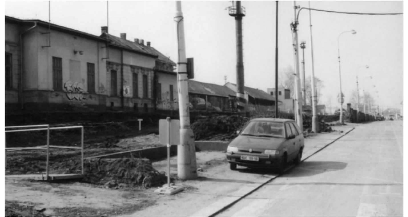
Prostor po snesené výtažné koleji vlečky před bývalým nádražím v roce 2003, prazsketramvaje.cz
