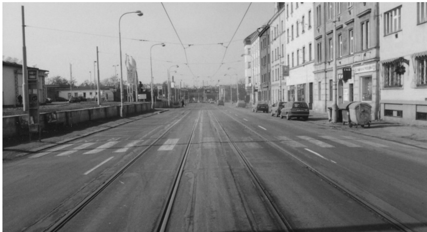
Českomoravská ulice před rekonstrukcí mezi lety 2003-2004, prazsketramvaje.cz
