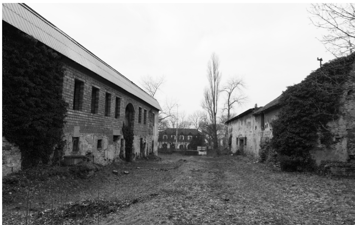
Současný stav severní fasády zámku a stáji. Při demolici mansardové střechy bylo zbořeno zároveň zdivo v patře. Zámek byl dodatečně opatřen pultovou střechou a zdivo hrubě doplněno.
