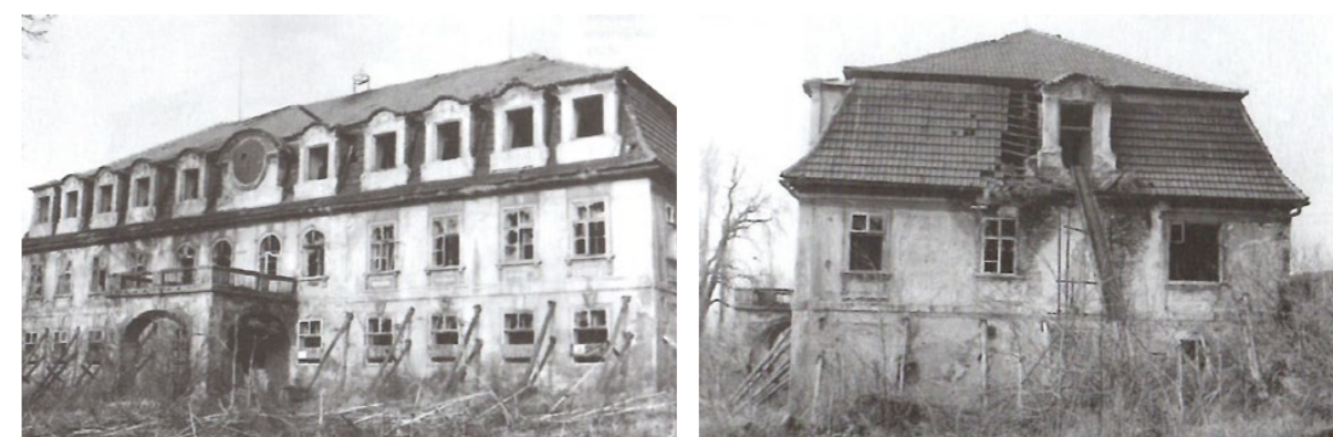
Pokračující chátrání zámecké budovy, stav 1990
