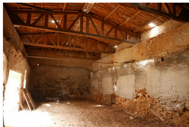
Interiér, střední novodobě zastřešená prostora
