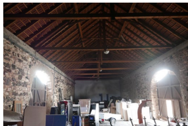
Interiér, pohled k jihu
