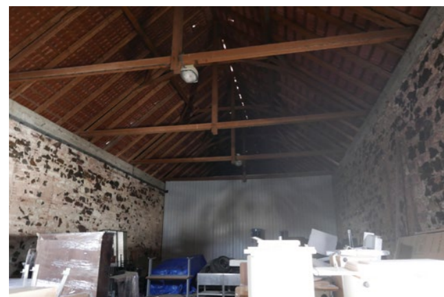
Interiér, pohled k jihu
