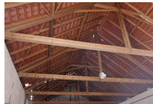
Interiér, pohled do krovu
