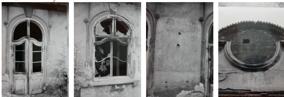
Detaily zámecké budovy
