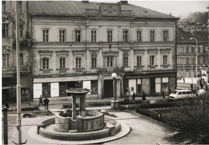
havarijní stav objektů těsně před demolicí 1977
