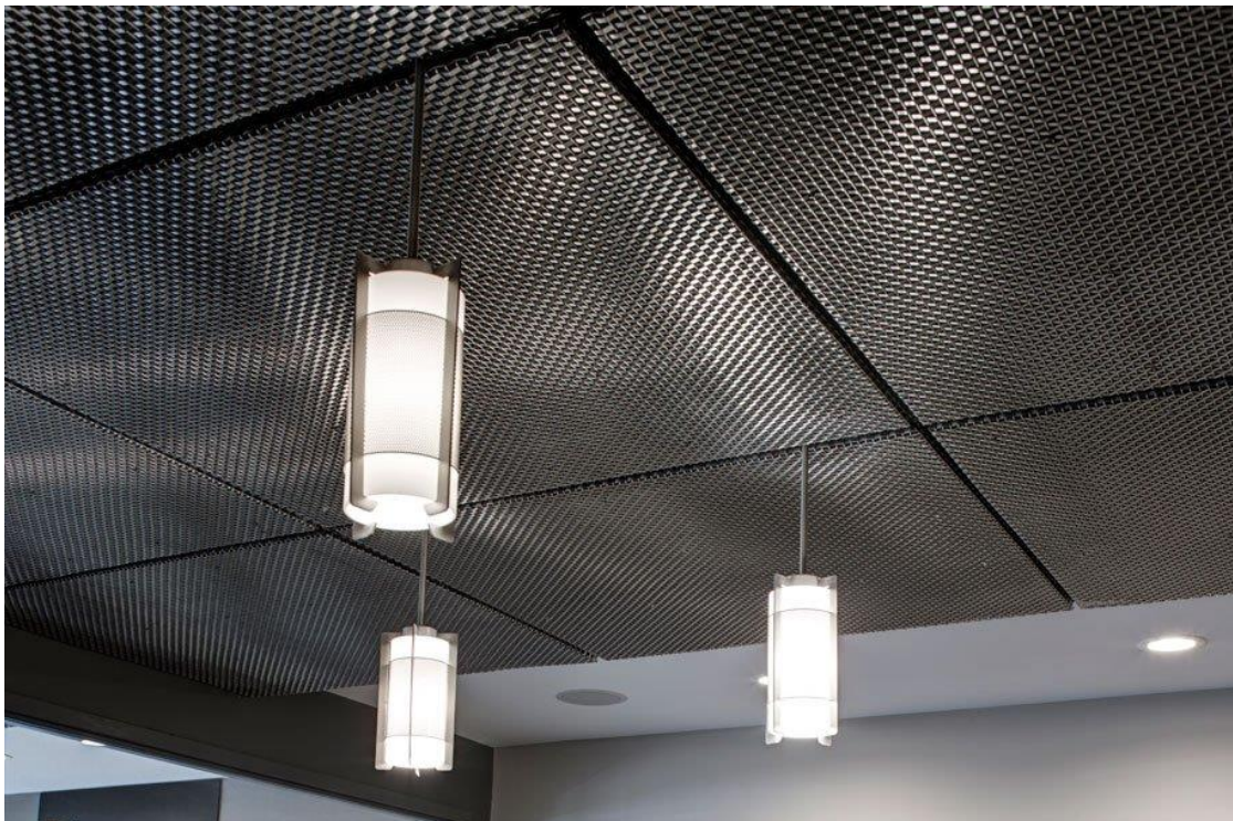
Referenčný obrázok – princíp umiestnenia závesných svietidiel do modulových špár stropného podhľadu
