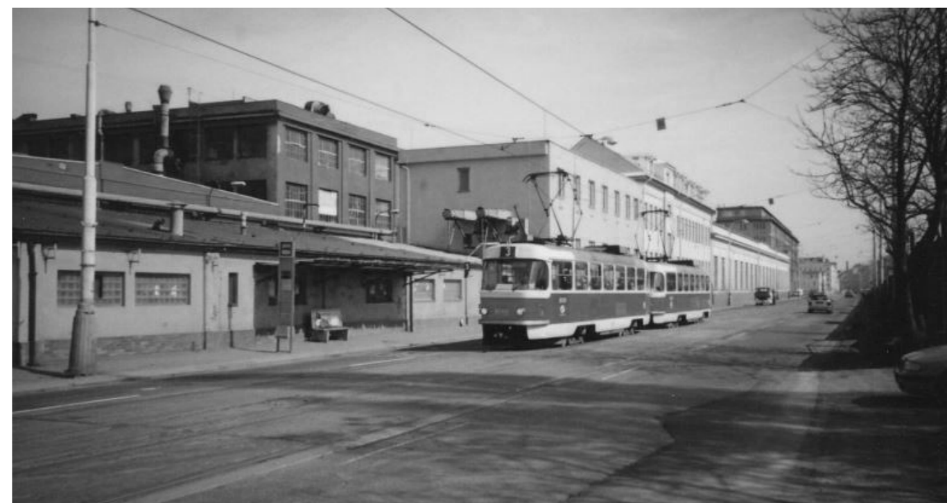
Zastávka Lokomotivka ještě před demolicí správních budov areálu ČKD 2.4.2001, prazsketramvaje.cz
