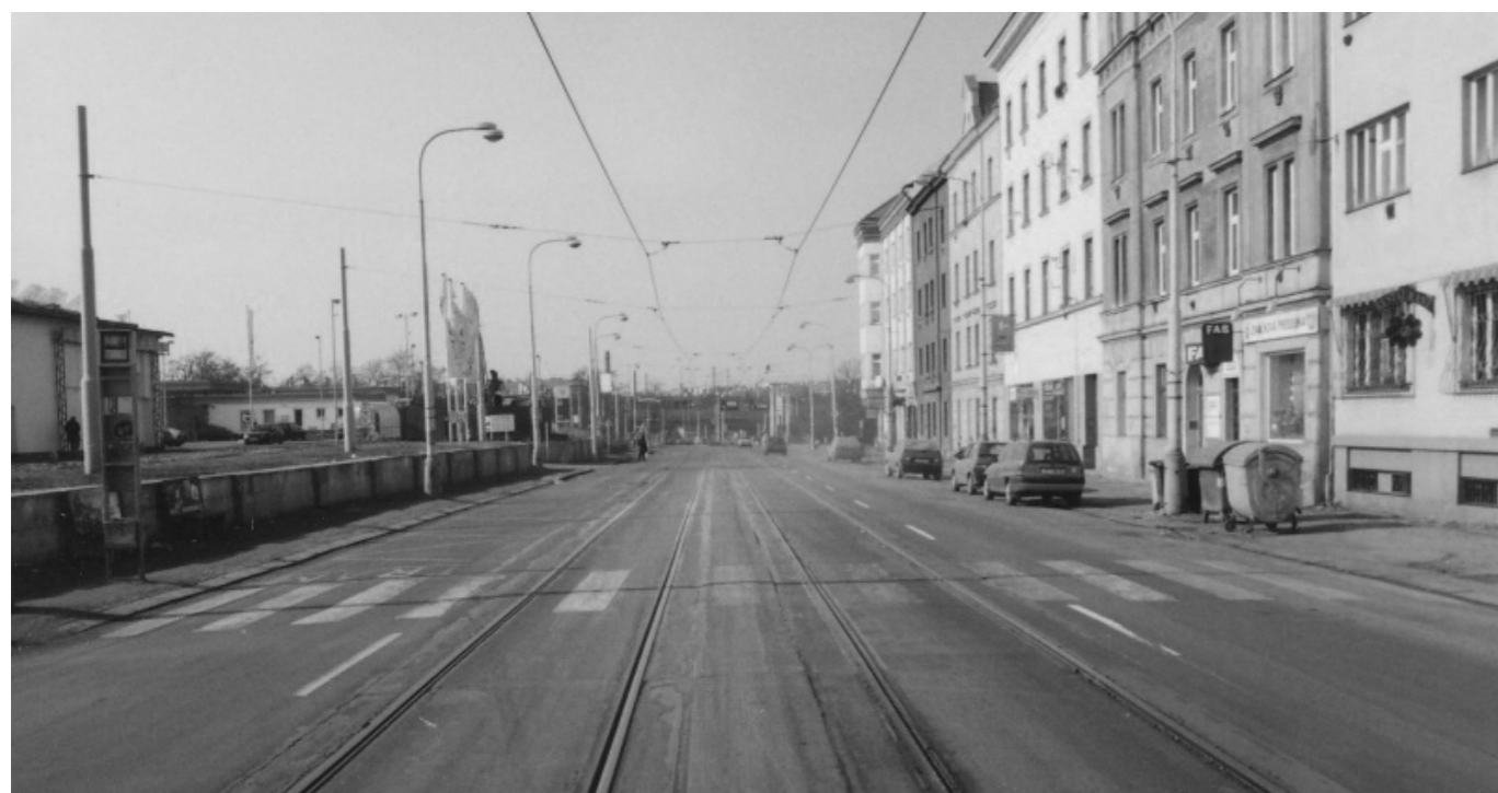
Českomoravská ulice před rekonstrukcí mezi lety 2003-2004, prazsketramvaje.cz
