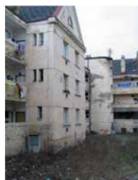
stav před rekonstrukcí v roce 2003
