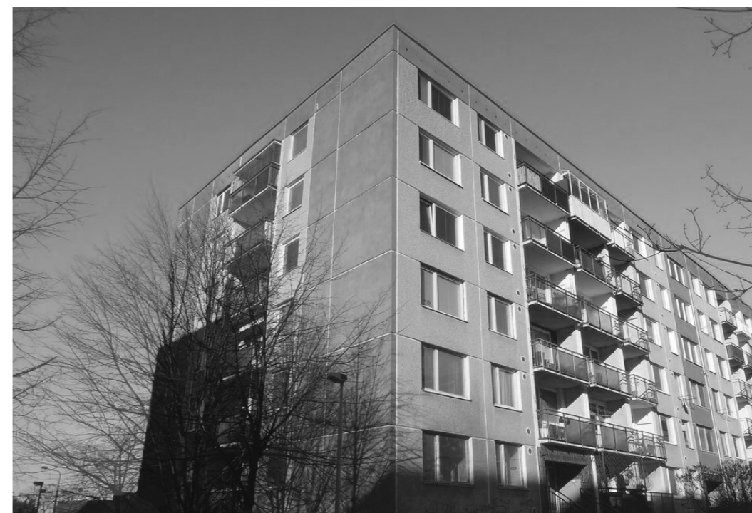
Charakteristické okenní panely tvaru „U“ a viditelné spáry, sídliště Nový Barrandov
