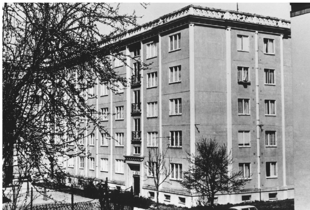
První celopanelový dům v ČSR (typ G 40), Benešovo nábřeží, Zlín
