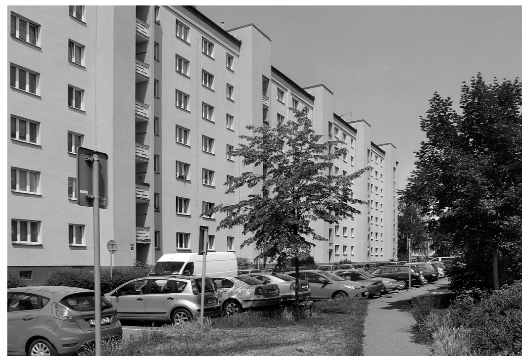
Varianta soustavy G57 s předsunutými schodišťovými chodbami, Petřiny
