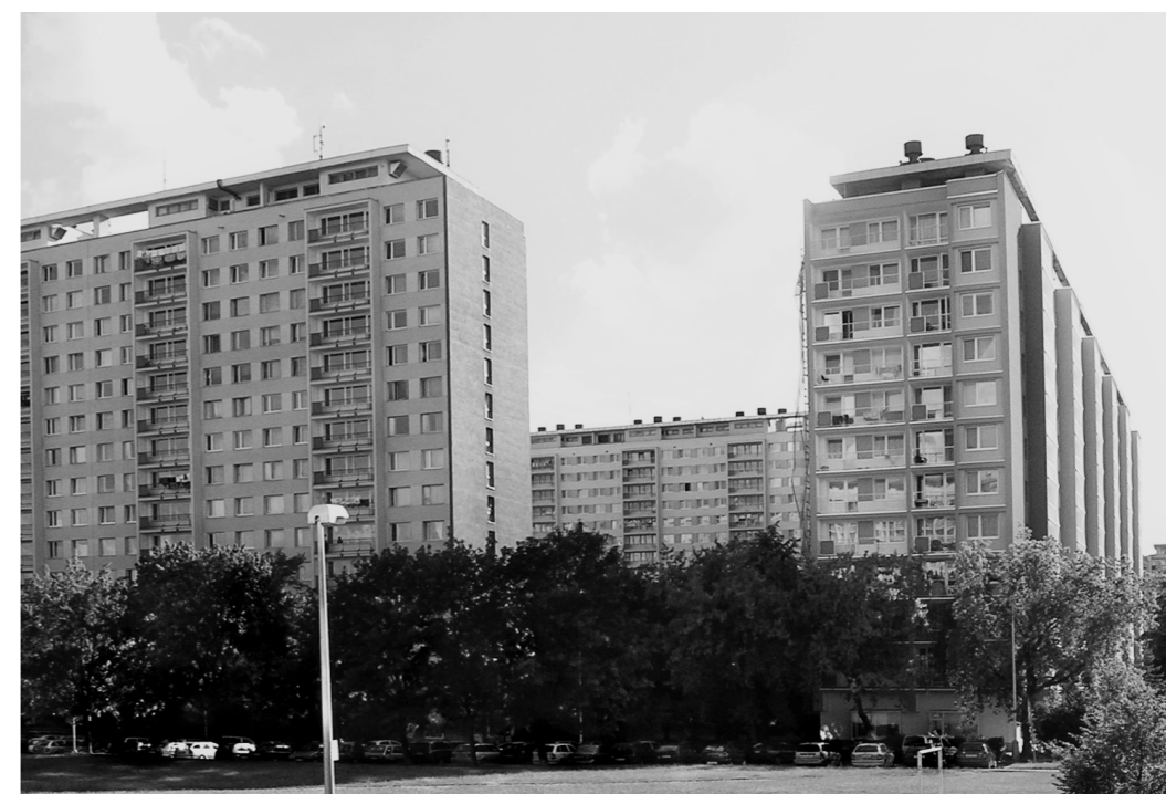
Využití štítové strany domu, Ďáblice
