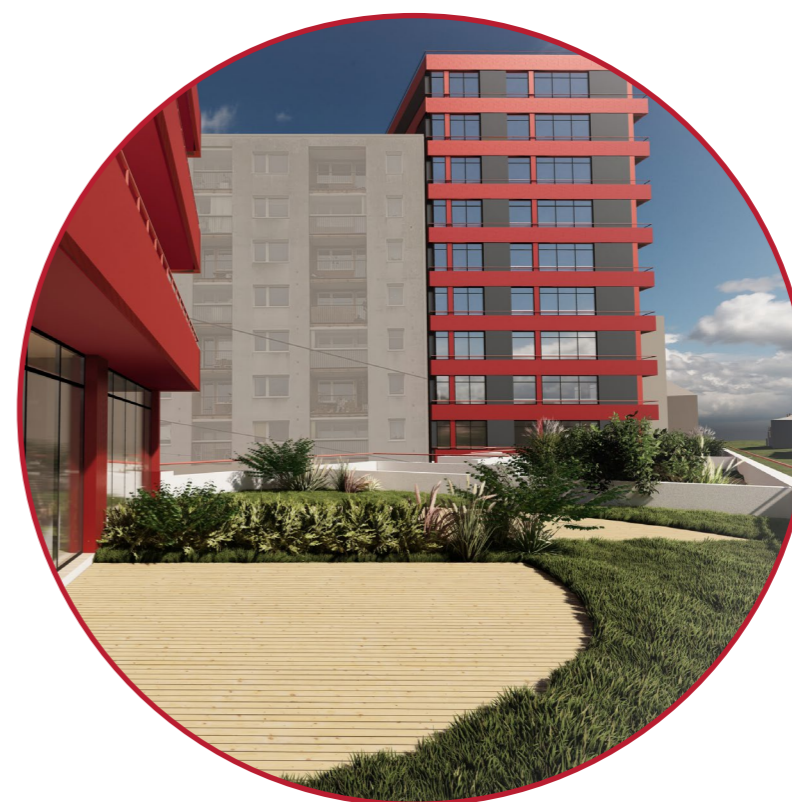
pohled na věž ze střešní zahrady
