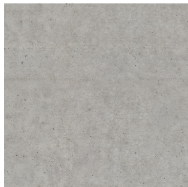
pohledový beton krystalický nátěr lodžie
