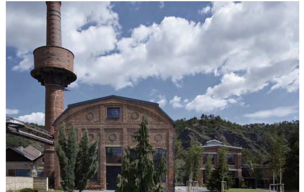
Kotelna v Libčicích nad Vltavou - ateliér Hoffman
