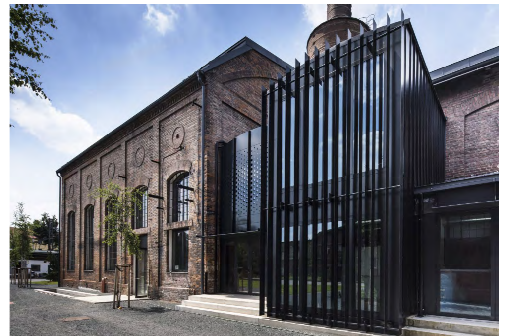
Kotelna v Libčicích nad Vltavou - ateliér Hoffman
