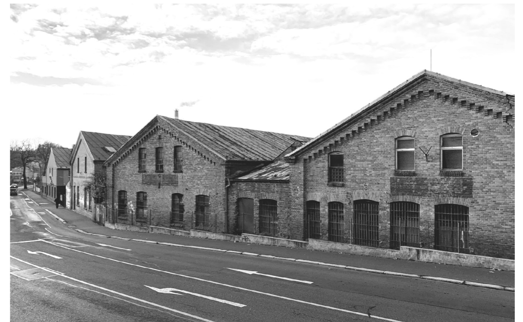
současný stav - průčelí z ulice Americká
