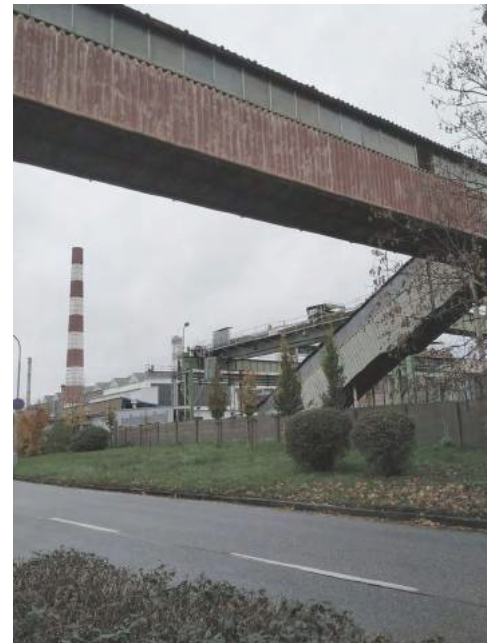
Kovárna, jeřáb, lávka do ZVÚ II
