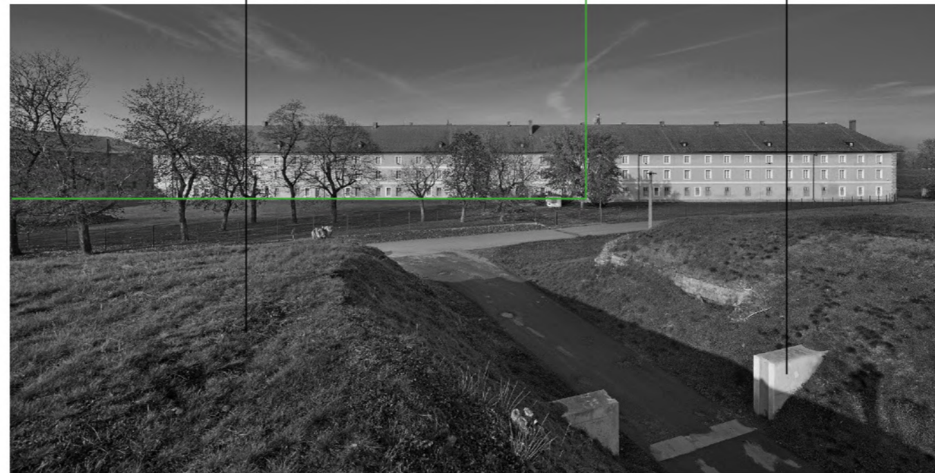
Rytmická fasáda kasárne v kontexte s pevnostným valom
