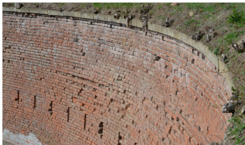
Pohľad na oblúk hradby
