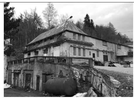
05: Vnitřní budovy areálu
