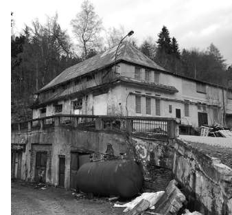
04| pod hlavním objektem
