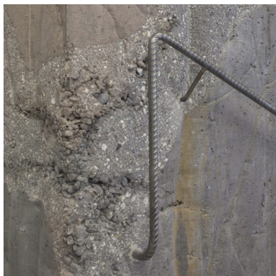
chemické kotvení zábradlí
