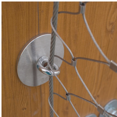
uchycení ocelových lan
