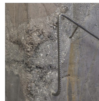
chemické kotvení zábradlí
