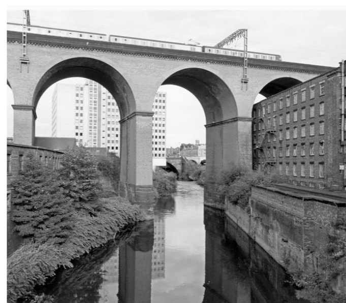
Stockportský viadukt, Manchester / John Davies
