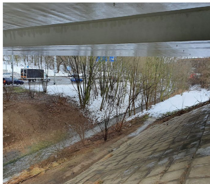
Motolský potok pod mimoúrovňovým křížením
