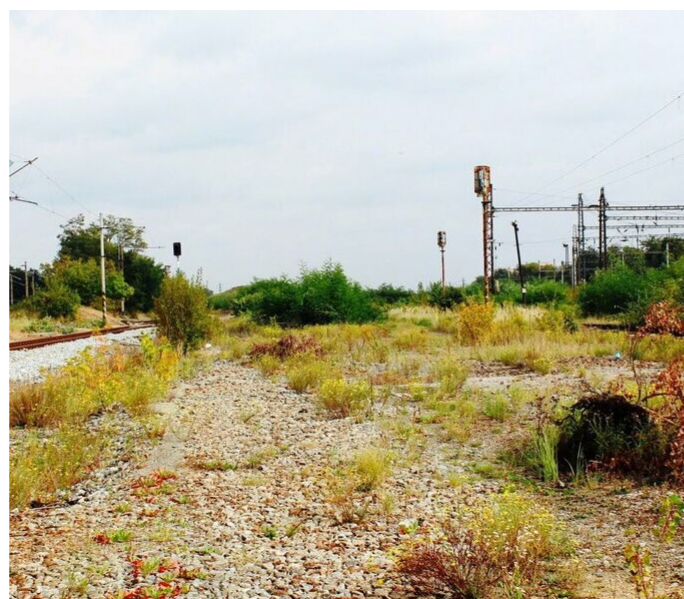
Kolejiště seřadovacího nádraží Vršovice
