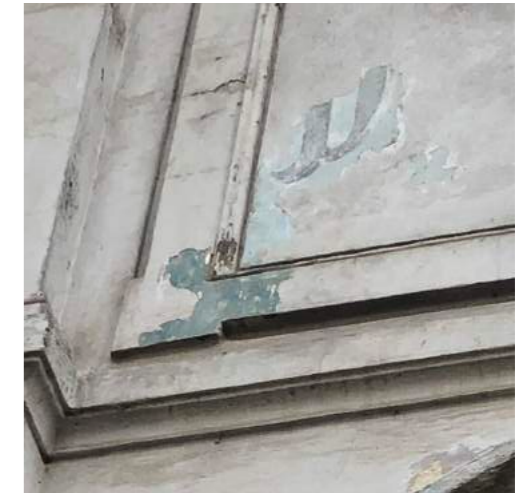
Odkrytí staré vrstvy omítky na čelní straně domu č.p. v ulici Dlouhá.
