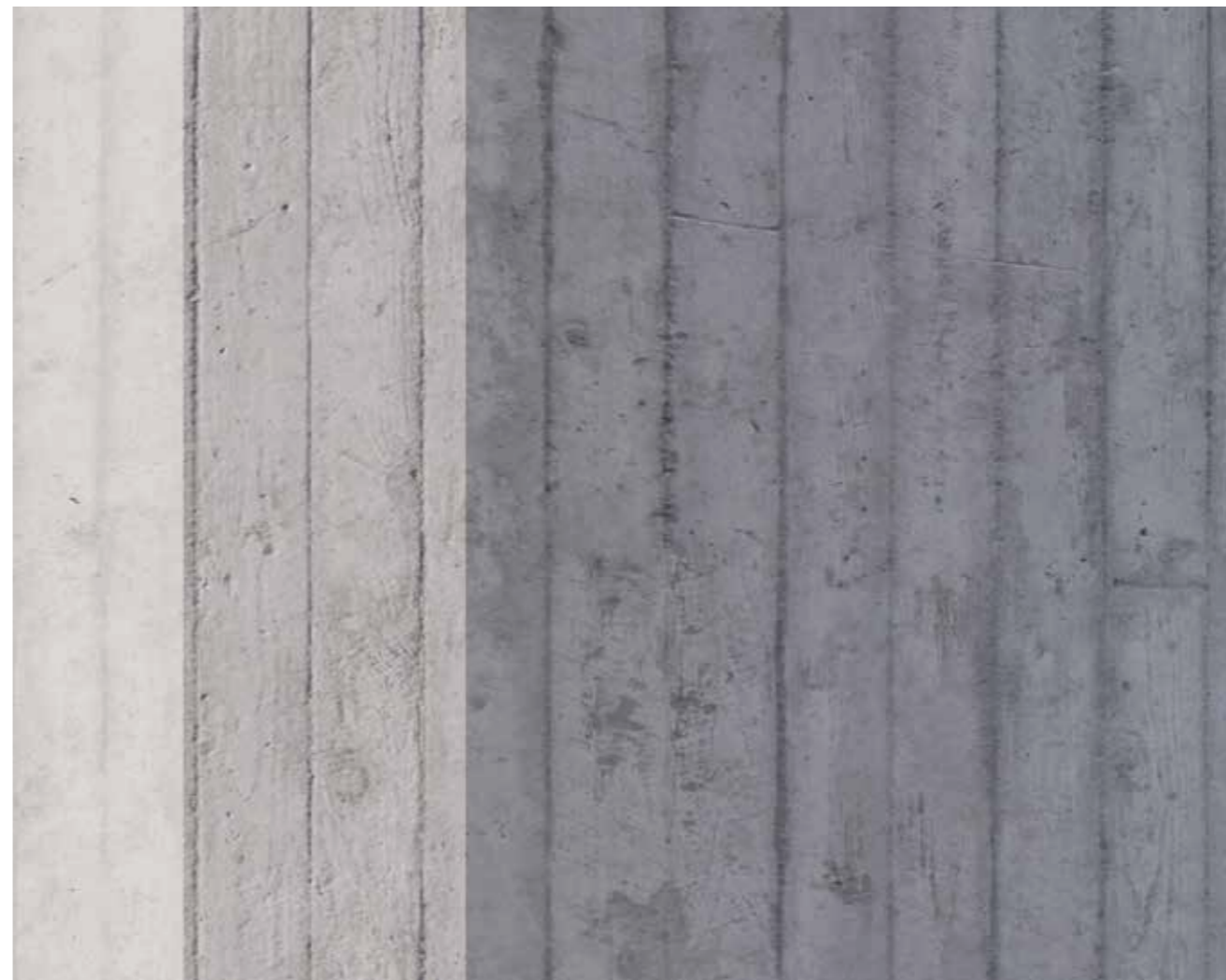
POHLED NA ZAVĚŠENÝ SKLOBETONOVÝ PLÁŠT
