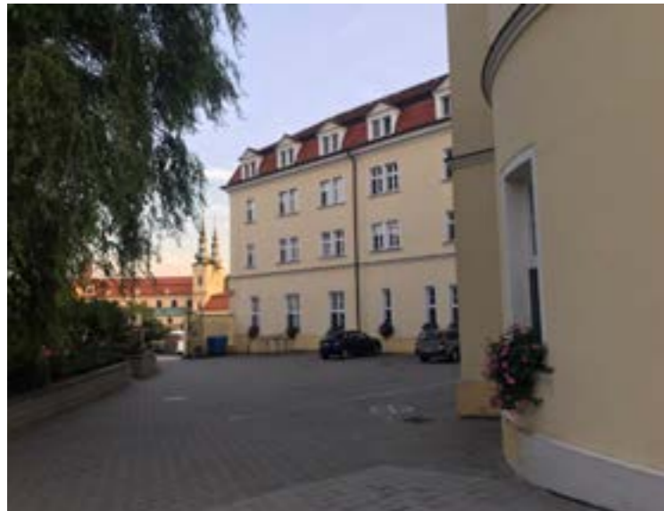
Poutní exerční dům Stojanov pohled ze dvora
