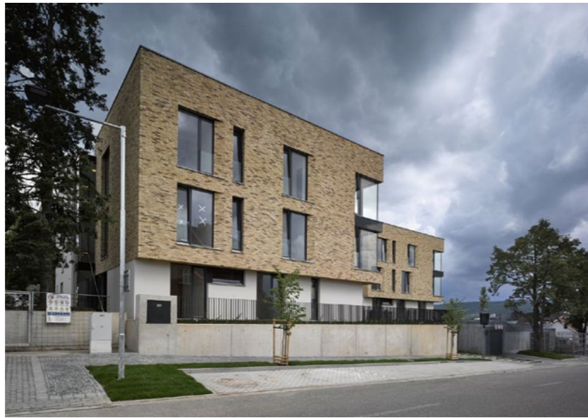
[obr. 4] zvýšená předzahrádka bytového domu
