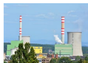
[obr. 44] Teplárna Kladno
