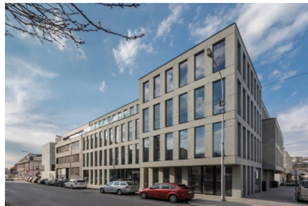
[obr. 28] administrativní budova
