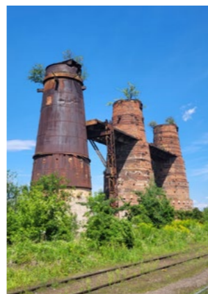
[obr. 9] tři věže vápenných pecí v areálu bývalé Vojtěšské huti
