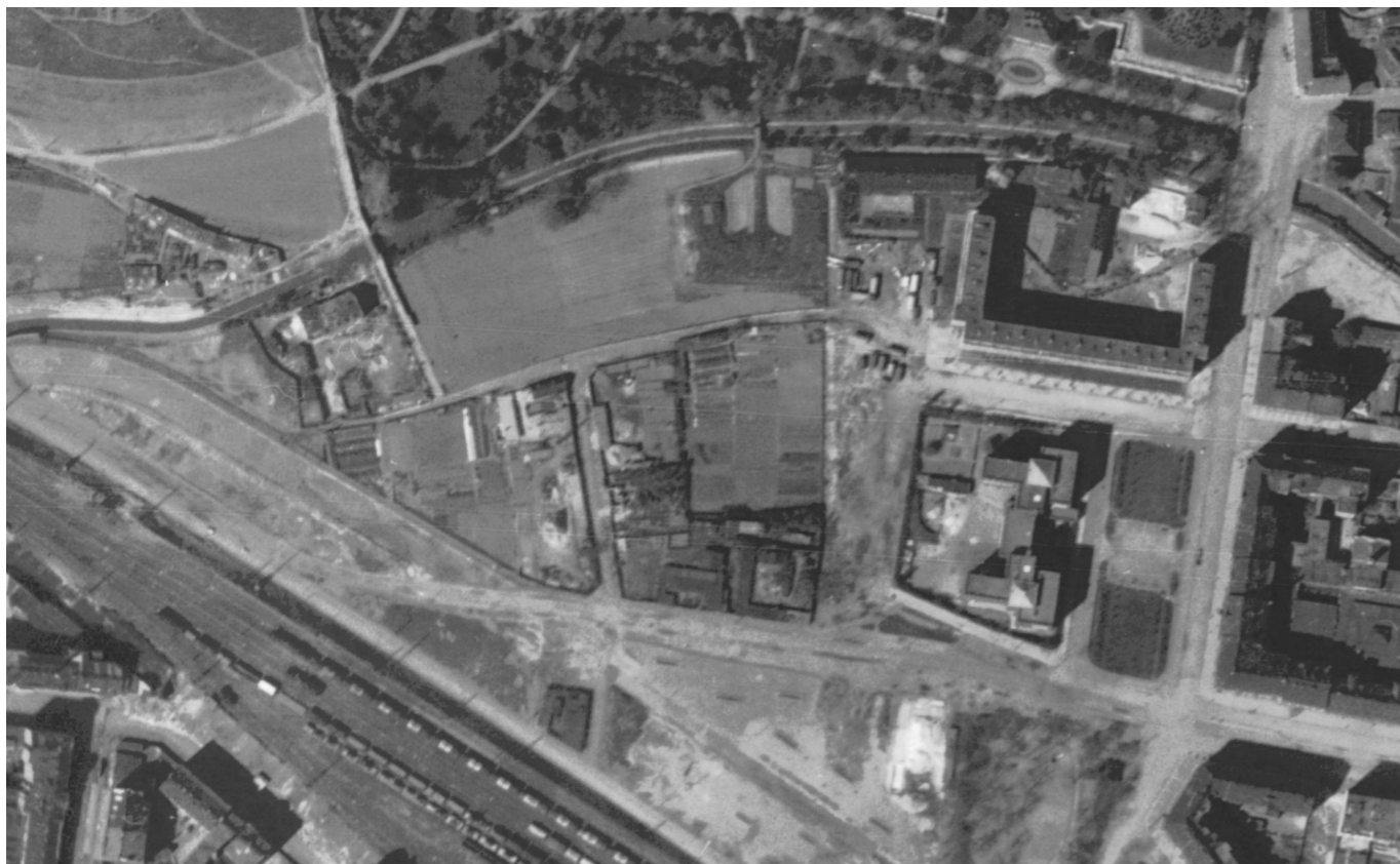
1945 prvorepubliková výstavba spodních Vršovic se zde zastavila
