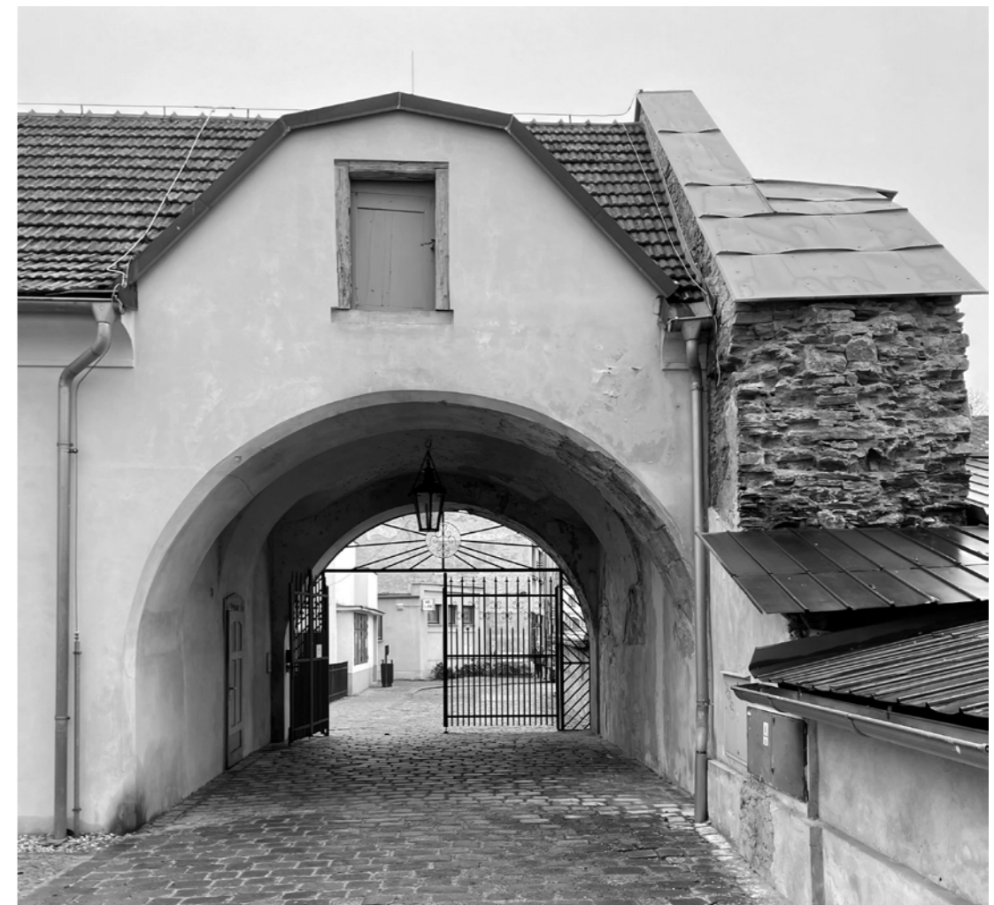
vstupní brána - východní křídlo sousedící s parcelou
