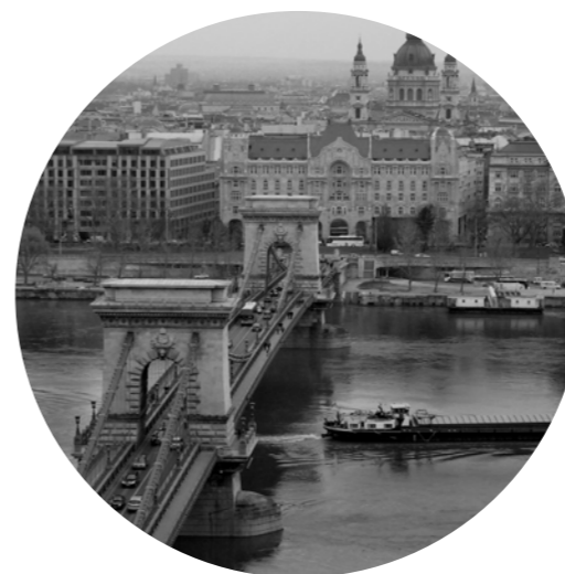
Széchenyiho řetězový most spojující Budín a Pešť
