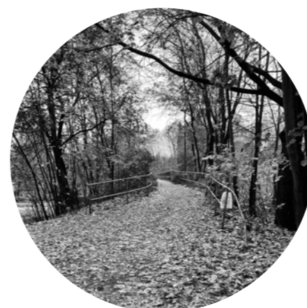
Současný stav doudlevecké lávky
