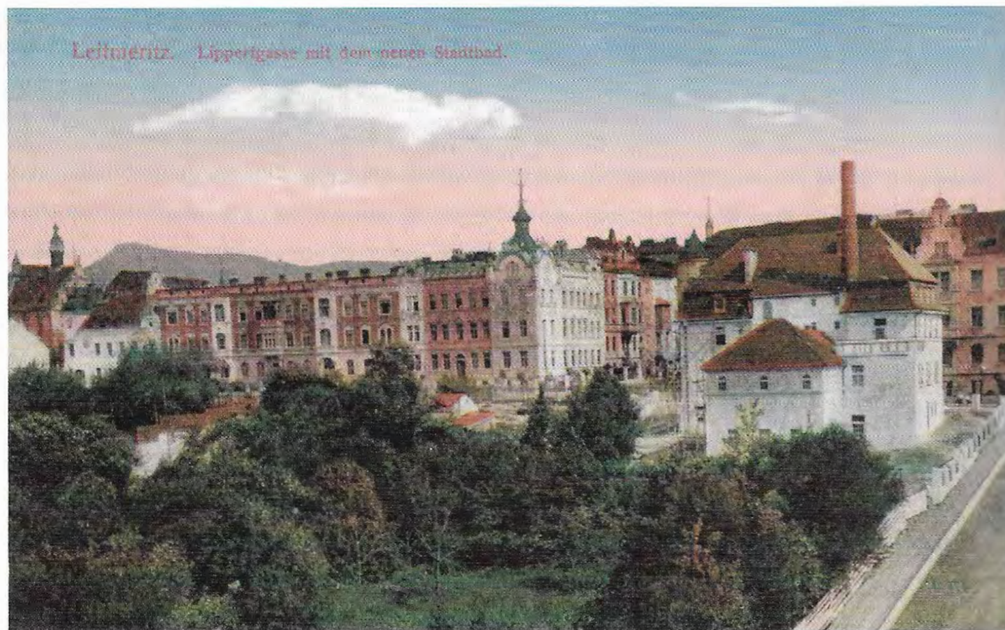
Pohled na bloky činžovních domů v dnešní Rooseveltově ulici, první domy vznikaly v roce 1880. Na pravé straně snímku je budova městských lázní, dnes přebudovaný hotel.
