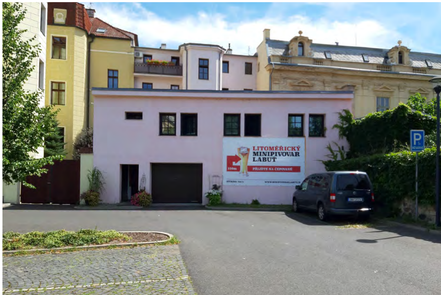
Budova se vstupem a vjezdy z parkoviště před zahradnictvím
