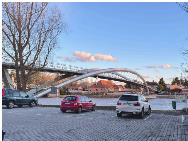
lávka přes Labe
