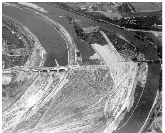
Letecký snímek z přeložení koryta Vltavy — 1926
