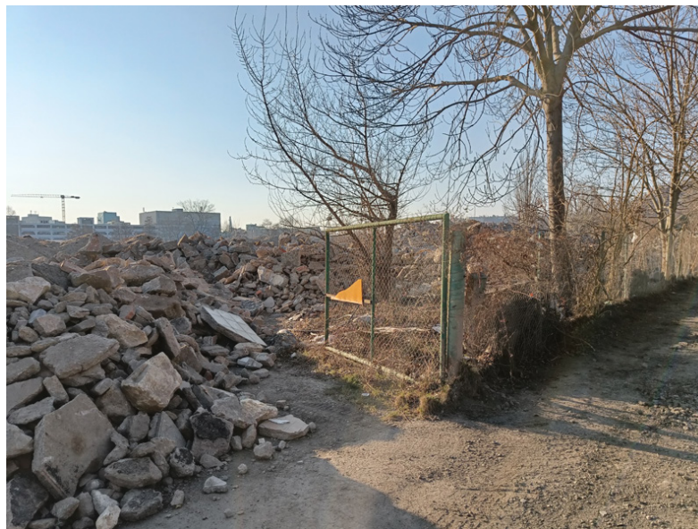
sklad stavebního materiálu
