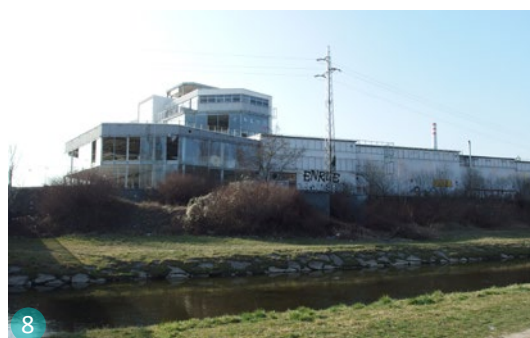
Zchátralá budova Cerimexu na levém břehu řeky. Nedávno zde pobývali bezdomovci, nyní čeká na demolici.
