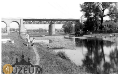
Železniční most ještě v jednokolejné podobě focený z druhé strany v roce 1930. Napravo od mostu se nachází papírenský mlýn. Před mostem je vidět jez s náhonem k mlýnu.
