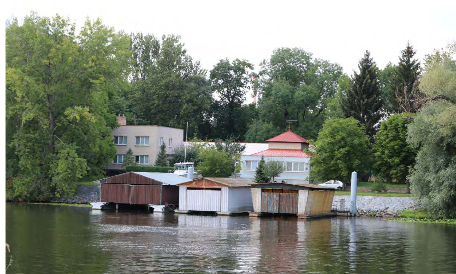
Areál poříční policie - pohled z levého břehu Labe
