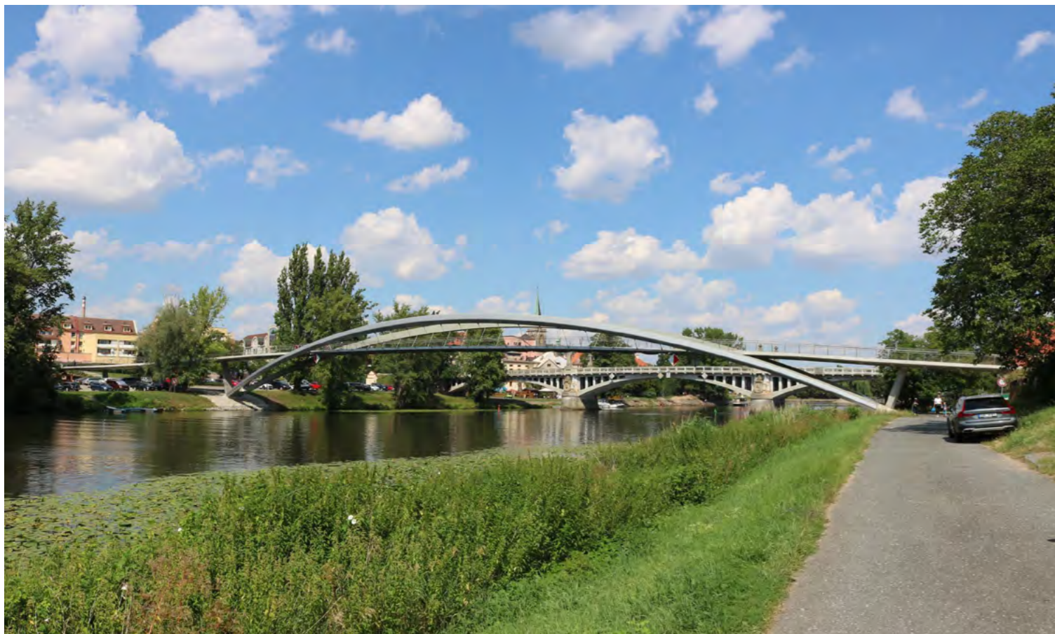
Most a lávka přes Labe - pohled z levého břehu řeky
