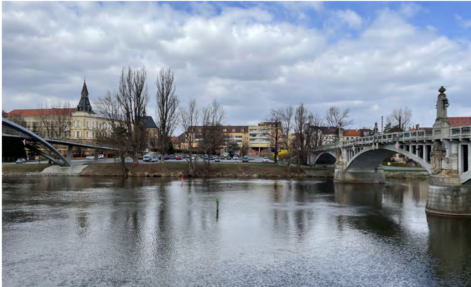
Pohled z levého břehu Labe - ZŠ Tyršova, pěší lávka, BD Eliška, silniční most, Labská cyklostezka
