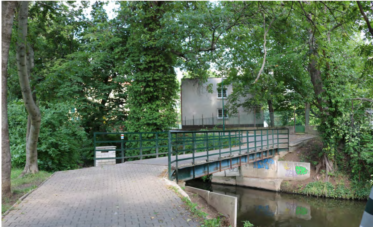
Lávka přes vodu z vodních příkopů - pohled na areál poříční policie
