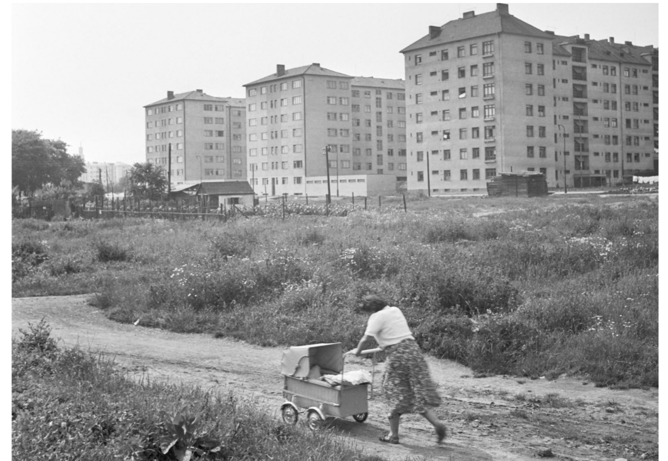
Bytové domy „V Zahrádkách,“ - 1951
