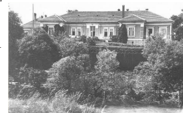
Obr. 17 Pohľad na nemocnicu od rieky na južnej strane od pozemku.
