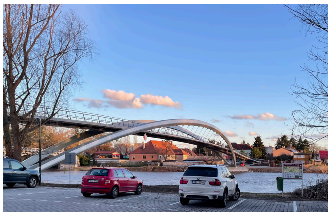
pohľad na lávku
