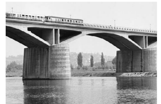
mohutný mostní pilíř
