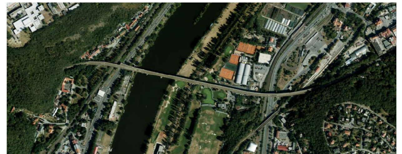
2018, rekonstrukce nádraží a nástupiště
