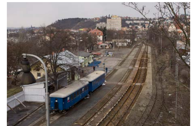
pohled na nádraží z mostu, cca 2010
