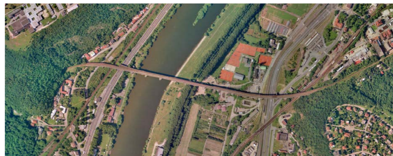
1996, počátek transformace zahradnictví, tržnice u tramvajové smyčky
