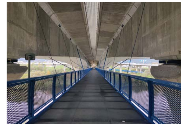
lávka pod Radotínským mostem přes Vltavu
