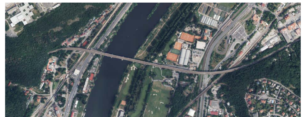
2021, nové P+R parkoviště, úprava profilu Modřanské
