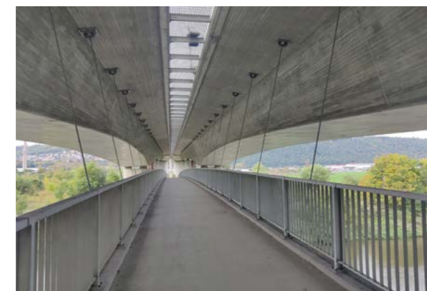
lávka pod Radotínským mostem přes Berounku
