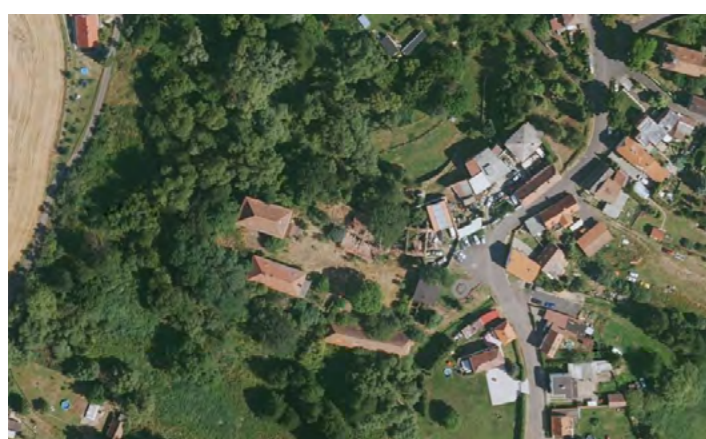
4./ 2022 Objekt po naději v podobě návrhu na vytvoření školícího střediska s ubytováním byl na začátku 90. let restituován a od té doby leží ladem a chátrá.
