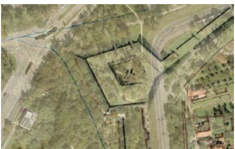
Bastion XI – Bastion Kamenný
