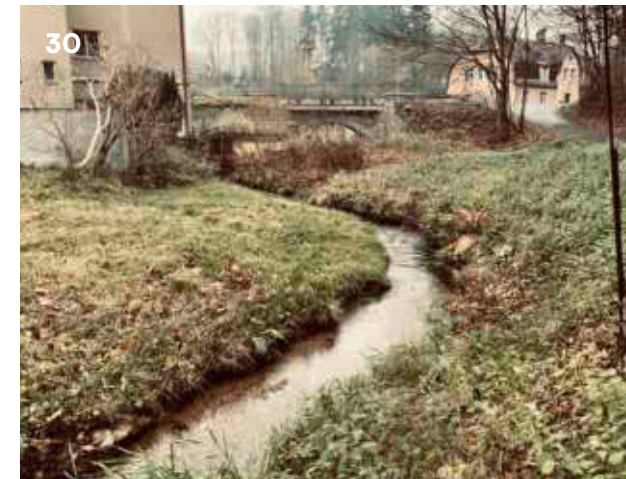
Foto. č. 30. Začátek aktivní záplavové zóny. Za mostem již řeku čeká dlouhý úsek regulace.
