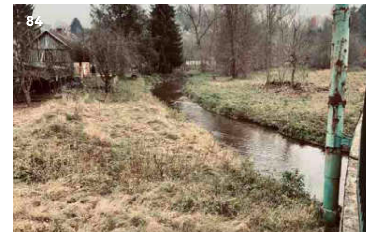
Foto. č. 84. Tramvajová trať spojující Liberec a Jablonec zde vede přímo přes řeku. Fungovat by měla opět v roce 2023.
