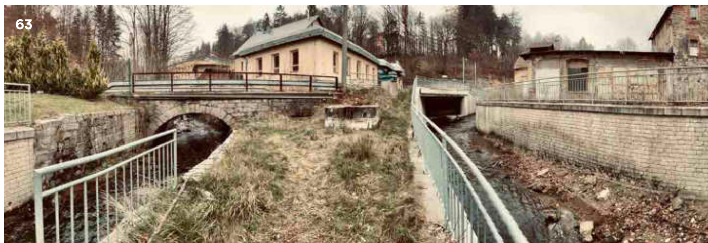
Foto. č. 63. Místo soutoku Bílé Nisy (Rýnovické - vlevo) a Lužické Nisy na spodním okraji obce. Obě koryta mají technický charakter a velkou kapacitu. V korytě Lužické Nisy je naplavěno spousta stavebního a jiného materiálu - cihly, keramika atd.
