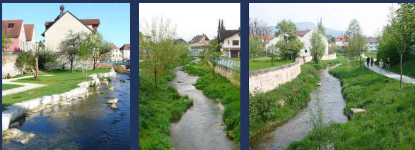
Obr. č. 8, 9, 10 – Intravilánová revitalizace vodního toku v bavorském městečku Bad Staffelstein. Jedná se o protipovodňové oživení toku, jehož koryto má nyní dostatečnou průtočnou kapacitu chránící zástavbu před škodami, vymezeno ochrannými zdi a valem, ale zároveň je přírodě blízkého charakteru a zvelebují veřejný prostor obce. (Zdroj: AOPK ČR, Ing. Tomáš Just, 2021)
