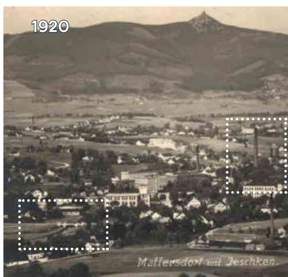
Obr. č. 76. Vlevo dole k vidění most přes zregulovanou Lužickou Nisu v ulici Dlouhomostecká. Vpravo je již vidět dostavená „Zauhlovačka“ a vodárenská věž, které stojí přímo na pravém břehu Nisy. (Fotohistorie.cz, 2021)
