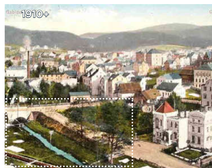
Obr. č. 88. Vlevo dole vidíme soutok zregulovaného Mšenského potoka (zděné kapacitní koryto vlevo) a regulované Lužické Nisy v místě dnešní tržnice vedle autobusového nádraží. Most přes řeku je v ulici Mostecká. V údolní nivě opět probíhá bělení prádla. Zde je krásně vidět, jak se ve městech snažila zástavba postupně dostat terénními úpravami nad hranici zaplavovaných ploch (viz. val nad údolní nivou). Vpravo je také vidět čerstvě postavený Jablonecký hrad Neysesburg — sídlo spolku Schlaraffia, zde zvané Preciosa Iserina. Bohužel v roce 2019 byla stavba zbourána. (FCB skupina „Jablonec nostalgický“, 2022)
