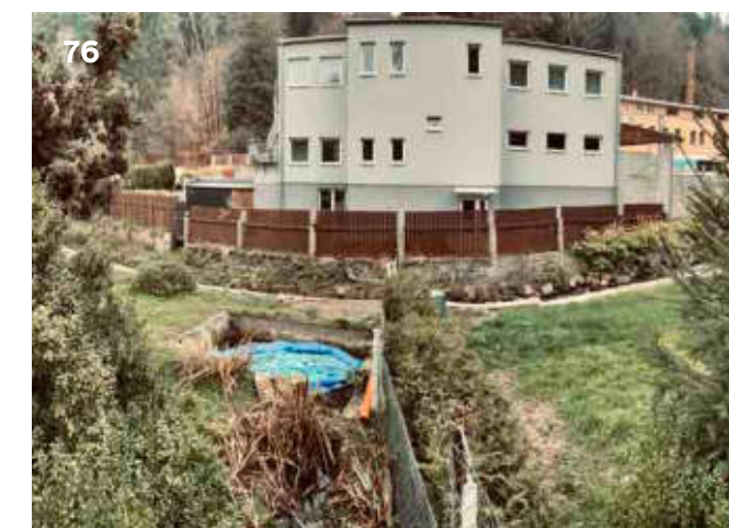
Foto č. 76. Nisa v údolí Proseče často protéká na hranici se soukromými pozemky. Zástavba stojí často přímo na hraně toku.
