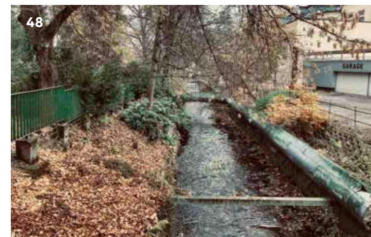
Foto č. 48. Ekologická i estetická degradace vodního toku, i veřejného prostoru. Vodní tok je oddělen od městského parku oplocením.
