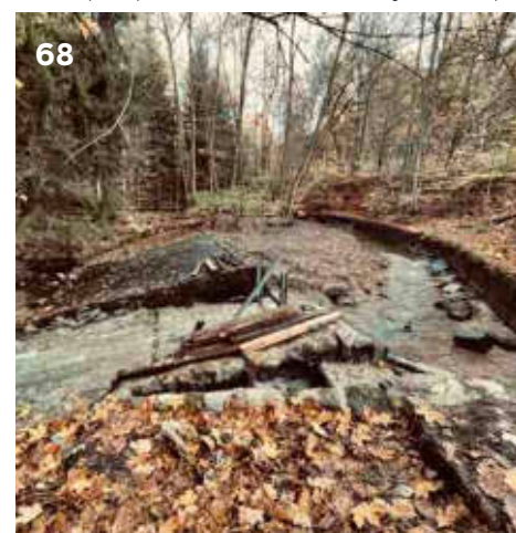
Foto. č. 68. Pod malou elektrárnou je koryto opět regulováno – je tu opevnění nárazového břehu, náhon (vpravo) a jez.
