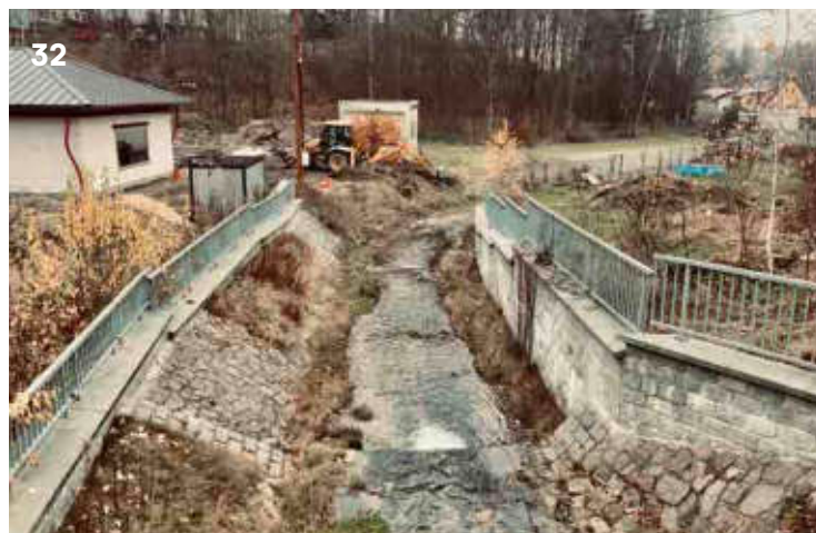
Foto. č. 32. Technická zkapacitňující úprava v místě první převodní štolý- začátek již souvisle zastavěného intravilánu Jablonce. Za zatáčkou převod vody do VD Mšeno.
