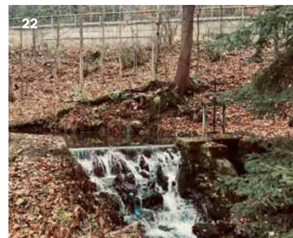
Foto č. 22. Za tímto menším jezem je na části toku více „klidných tůň“ a ryb. Jez zde představuje významnou migrační překážku.
