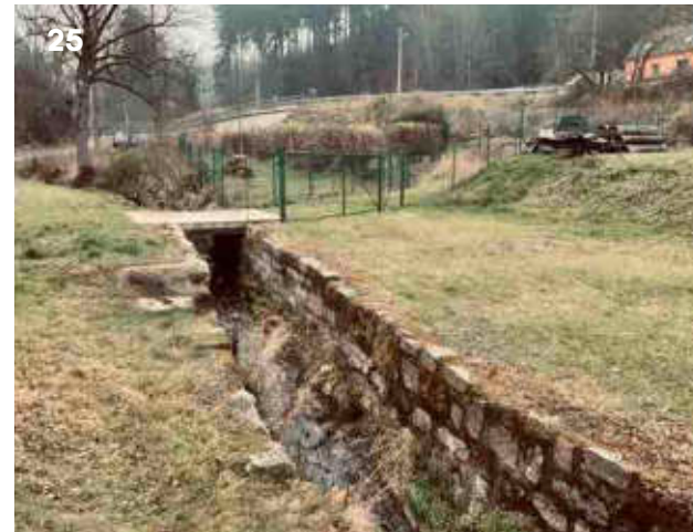
Foto. č. 25. V místě zástavby je opět tok regulován, zahlouben do stabilního zpevněného koryta.
