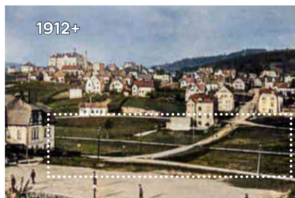
Obr. č. 93. Opět pohled na zatím nezastavěnou údolní nivu Mšenského potoka (zahlouben a regulován uprostřed). Regulace zde jako na jiných místech realizována v rámci protipovodňové ochrany. (Tamtéž)
