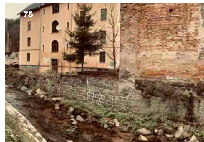
Foto. č. 75. Charakter na horním okraji Proseče kontrastní oproti fotkám viz. výše. Zde regulované, zhloubené koryto. Zástavba využívá každý metr údolní nivy. Koryto řešeno jako kapacitní a regulované. Dno je ale stále dostatečně členité.
