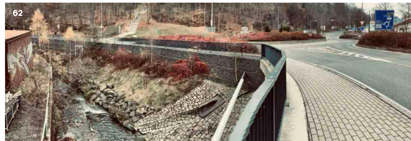
Foto. č. 62. Terén města je na jeho západním okraji již 4-5 metrů nad řekou. Na levém břehu, vysoko nad řekou stojí zástavba. Pravý břeh má oproti levému přírodnější a členitější charakter, je ozeleněn a na patě zpevněn záhozem velkými kameny.
