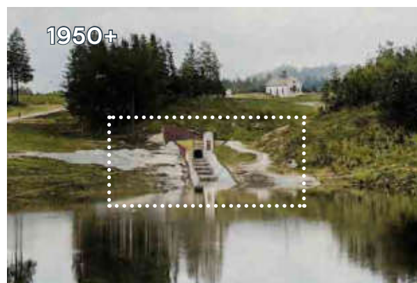
Obr. č. 95. Zátoka „Cikánka“ na Mšeně — 633 m dlouhá Pasecká převodní štola. Obě štoly převádějící povodňové průtoky musely být roku 2011 zvětšeny kvůli nedostačující kapacitě koryt toků pod rozdělovacími objekty. (Tamtéž)
