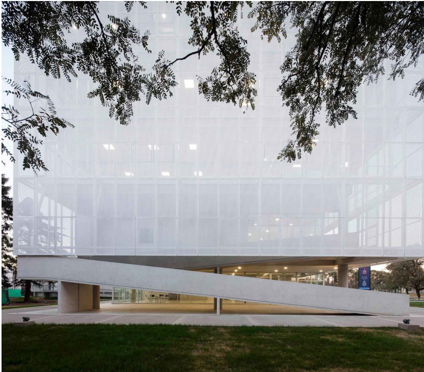
① Hlavní pohled
