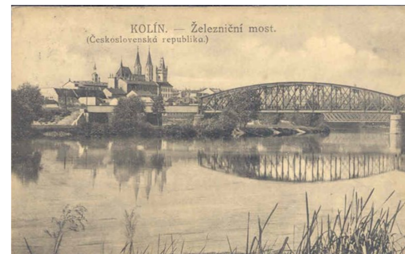
PŮVODNÍ ŽELEZNIČNÍ MOST Z R. 1908-1910
