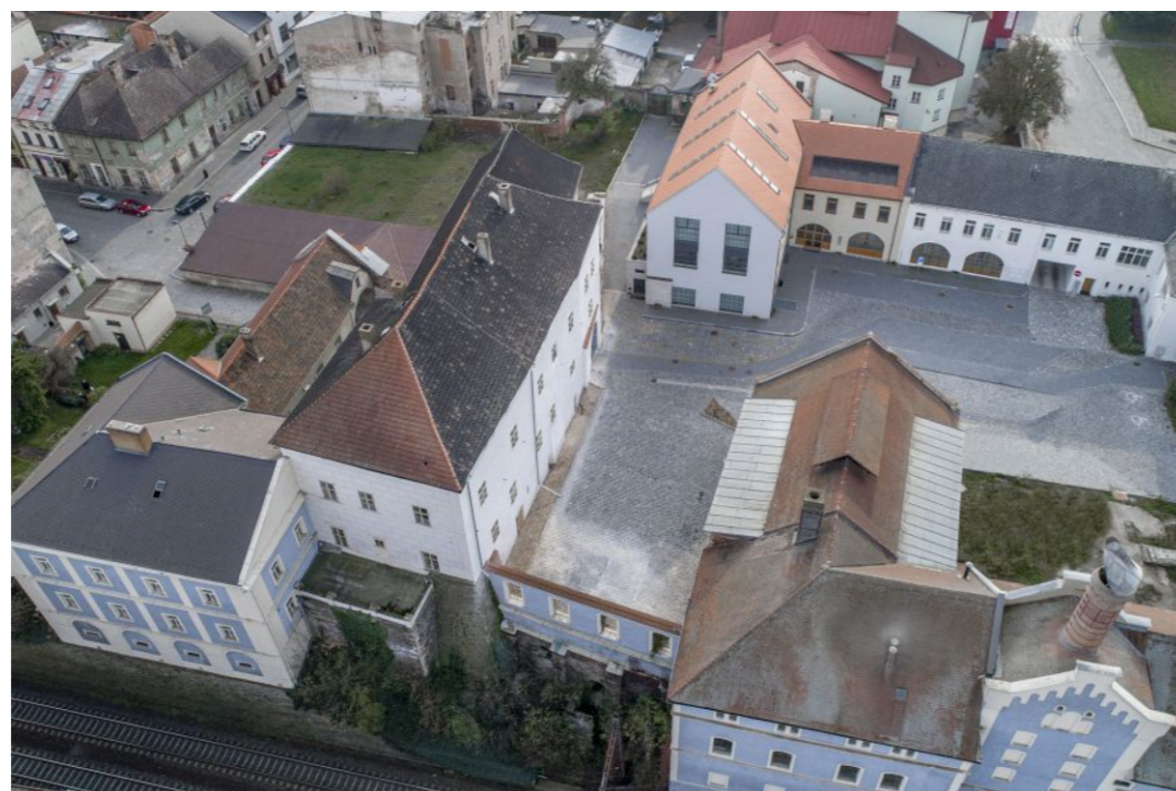
POHLED ZE SEVEROZÁPADU
