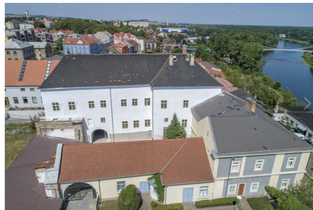
POHLED Z VÝCHODU
