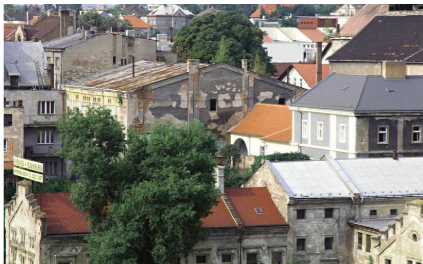
OBJEKT JEČŇŮVŮV PŘED DEMOLICÍ
