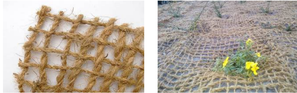
Ukázka vhodného sortimentu a použití stabilizační kokosové sítě. Po rozložení síť působí jako hnojivo. zdroj fotografií: https://www.geomall.cz/kokosova-sit-pro-zpevneni-svahu-geomant-k-eko?gclid=Cj0KCQjwmuITBhDoARIsAPiv6L9y4Az9adzjK65WI-ZswcpYU-TNB0q6wcvBR5pD_ukeZXNPNI89WMAp6fEALw_wcB#
