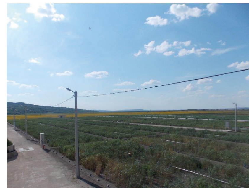
Obr. 36 Dosud největší kořenová čistírna vybudovaná v Orhei v Moldavsku (Iridra 2018)
