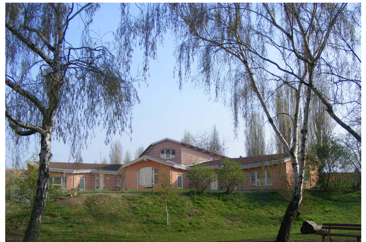
Strohballenbau Waldorf Preschool Leipzig / Architekturbüro Denker & Zimmer
