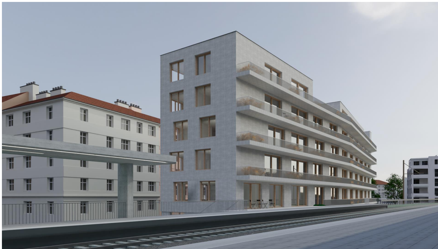
POHLED ZE STANICE
