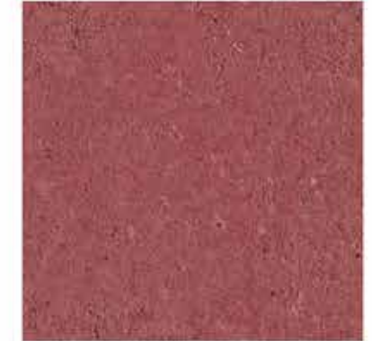
Nátěr ŽB stěny, RAL 3011
