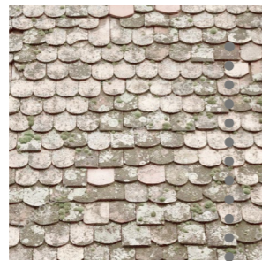
Stávající krytina Bobrovka Lokálně vyměněna
