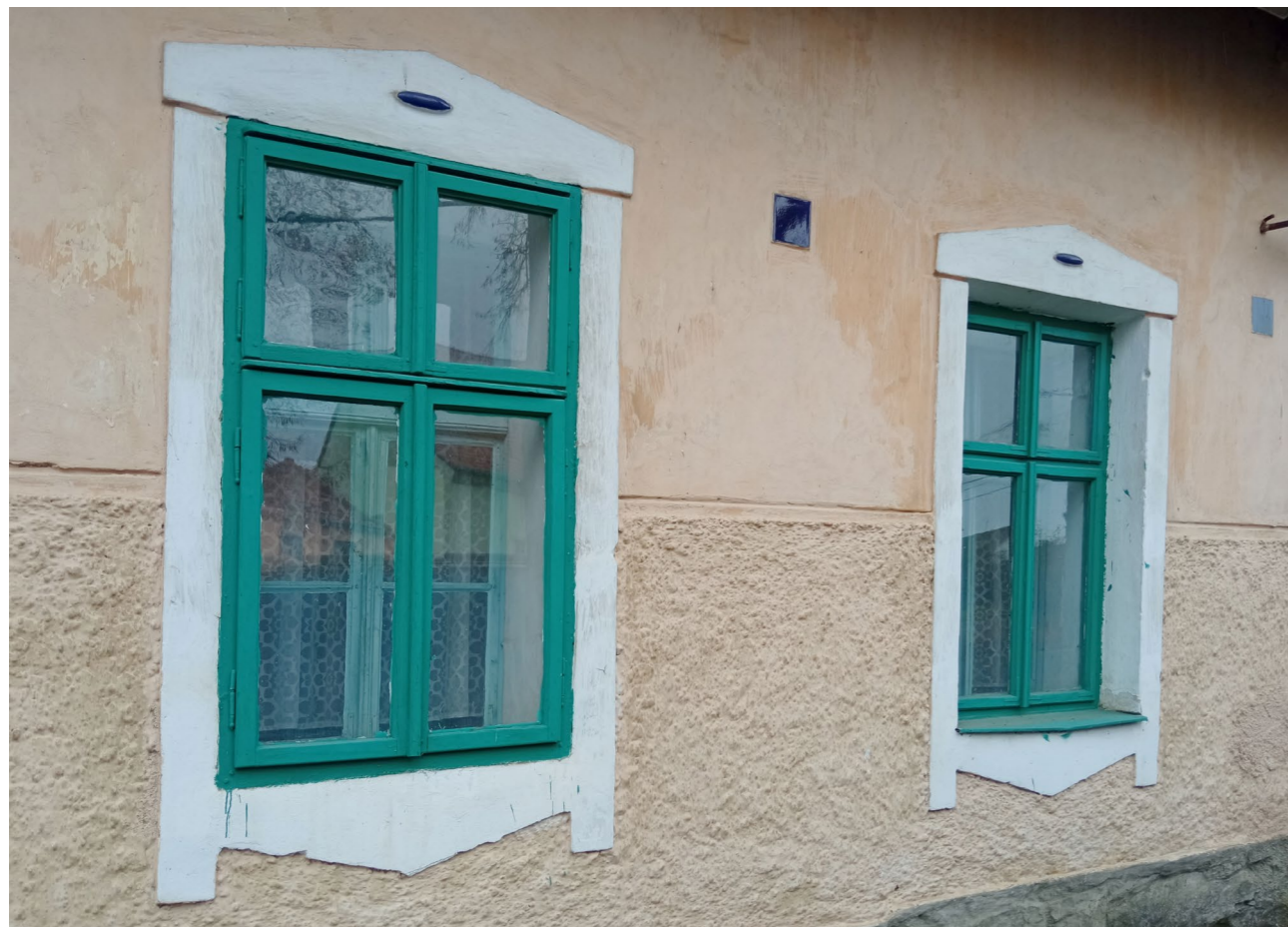
Detail špaletových oken obytného stavení, které pocházejí z přestavby z 20. let 20. století.
