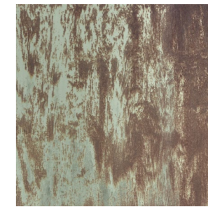
Stávající kovové povrchy
