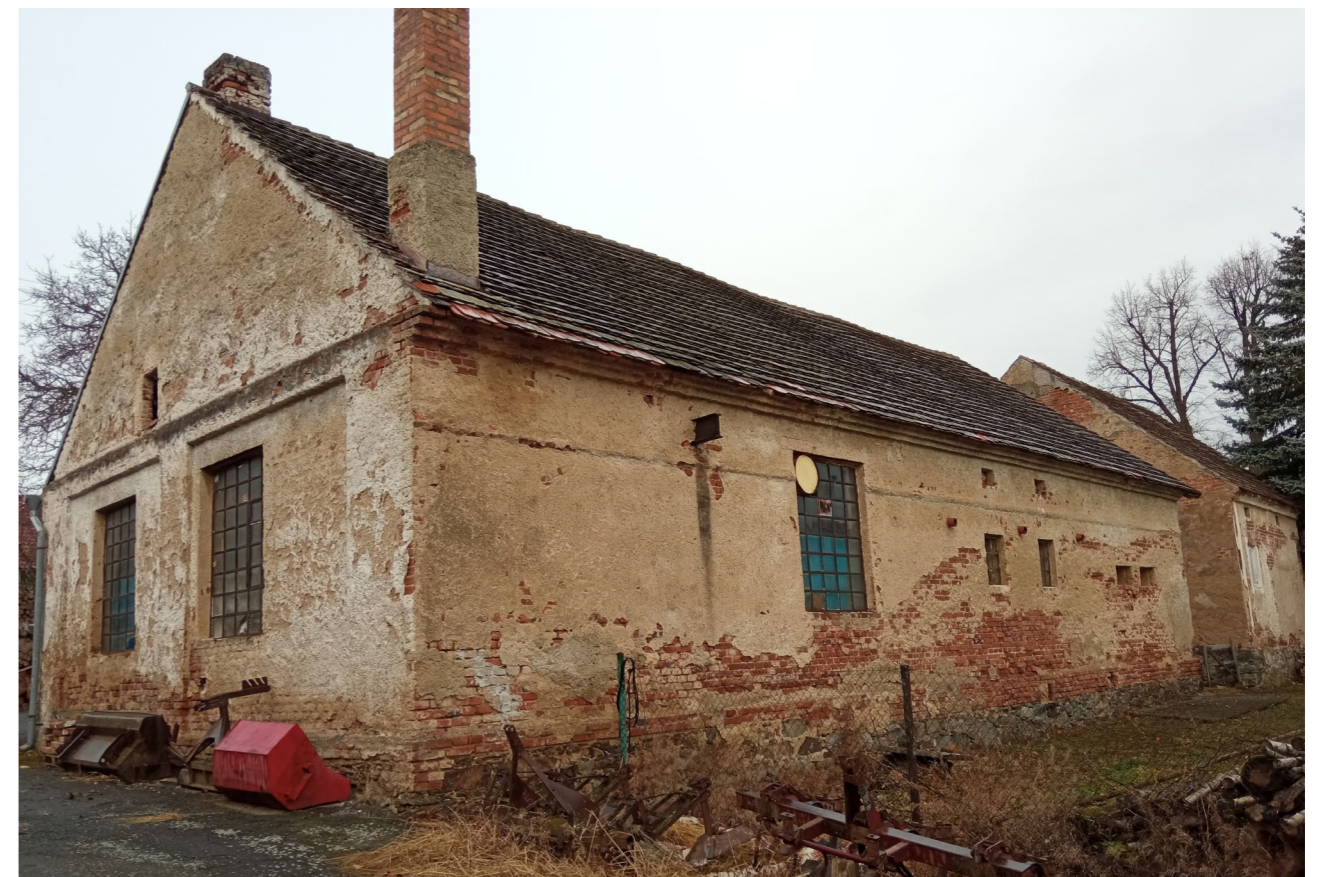
Objekt garáží z 20. let 20. století, pohled z jižní části areálu.
