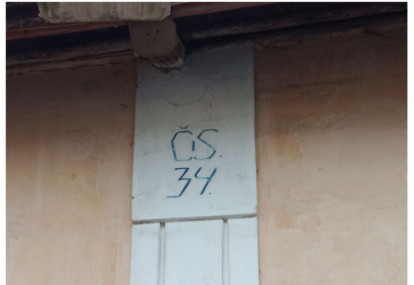
Nápis ČIS. 34. na čelní fasádě obytného stavení k návsi z období 20. let 20. století.
