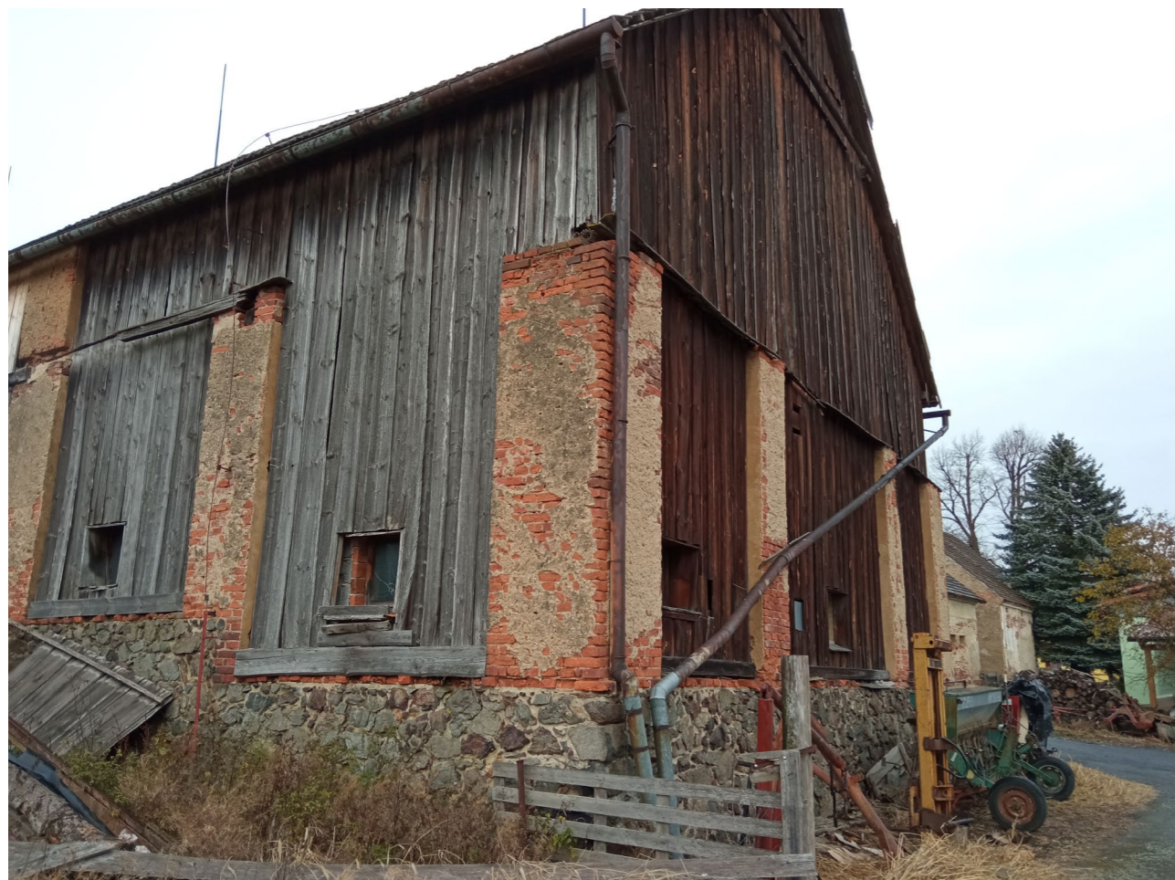
Západní strana stodoly s dřevěným krytím.
