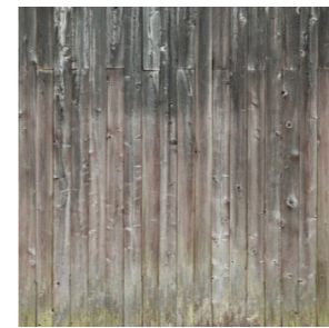
Stávající dřevěná prkna
