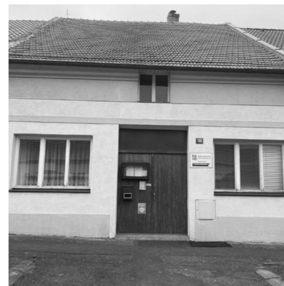
současná budova ZUŠ Kouřim
