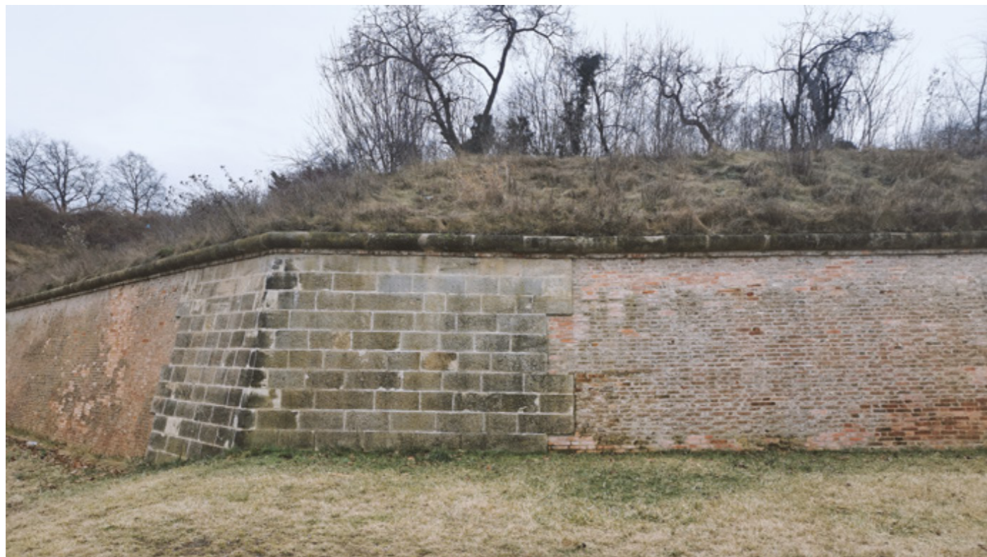
foto: autor publikace, zpevněné nároží bastionu
