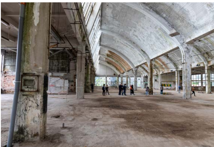
Hala č.19 - interiér
