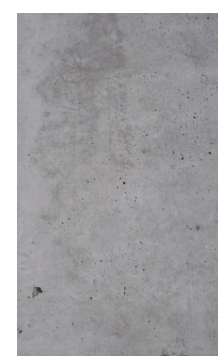
podhledový beton transparentní odháněný náter na předních částech schodiště
