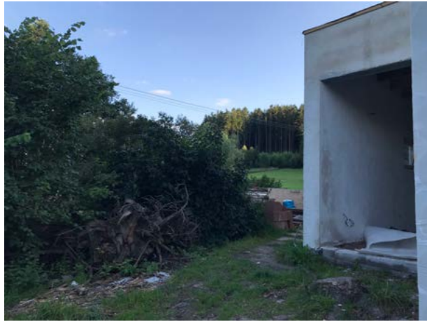
1 Roh garáže, východní roh domu.
