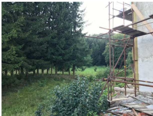
3 Jižní roh domu, pohled do svahu.
