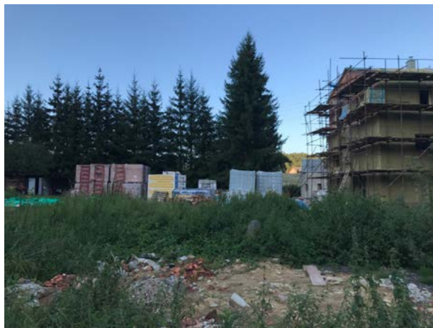
5 Pohled na stavbu přes zatrubněný úsek potoka.
