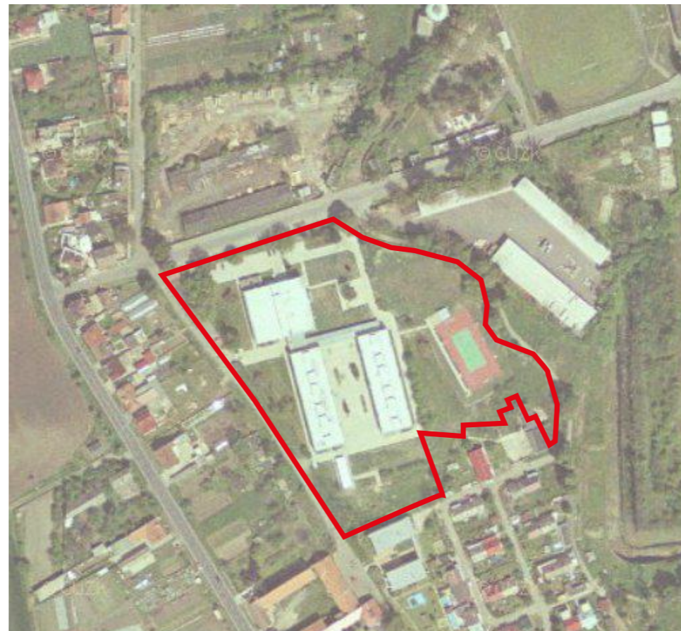
letecký měřický snímek 2005 Vedle budovy ZŠ je umístěno atletické hřiště.
